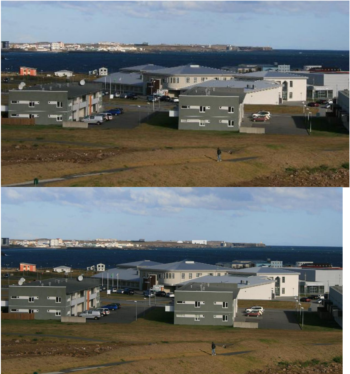
Mynd 6.13: Kísilverksmiðjan í Helgúvík frá Innri-Njarðvík (staður 1 á mynd 6.12)
